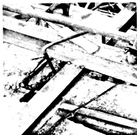
图8 连梁与悬挑梁连接实拍
